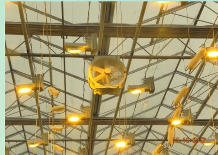
В состав системы входят осевые вентиляторы и электротехническое оборудование, управление осуществляется в автоматическом режиме.
