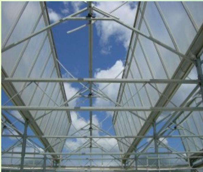
✓ Вентиляционные фрамуги теплицы, соединительные элементы, механизмы привода открывания фрамуг являются составной частью каркаса теплиц, и относятся к инженерно-технологическим системам, выполняющим функции управления микроклиматом.
